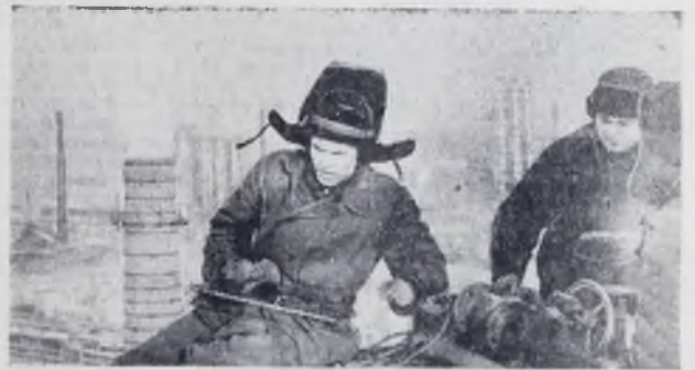
Вот она, самая высокая точка ЭЛОУ АВТ. Здесь, на вершине колонны К-2, бесстрашные монтажники Иван Степанов и Василий Власов заканчивают обвязку колонны. Фото В. НЕБОГИНА.
