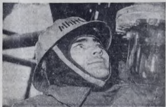
Когда вновь строящийся дом уже вот-вот будет готов, в нем загораются яркие огни. Так и здесь, на ЭЛОУ АВТ. Электромонтажник Геннадий Яковлев (из бригады А. Голубева) ставит последние светильники, большие, крепкие, сделанные надежно, на века!
