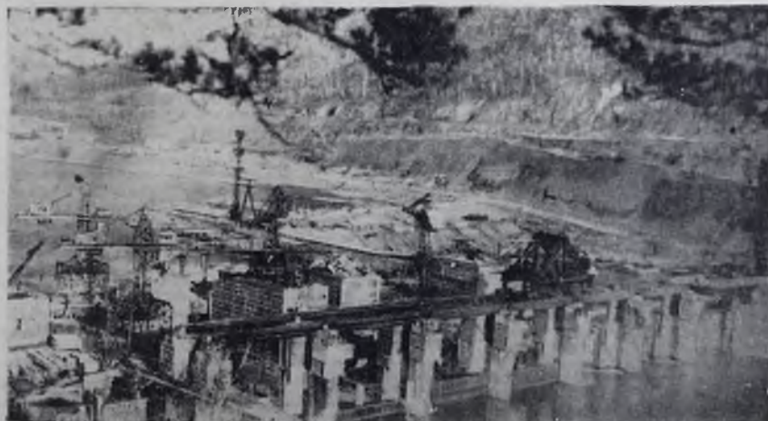
НА СНИМКЕ: панорама строительства Красноярской ГЭС.
