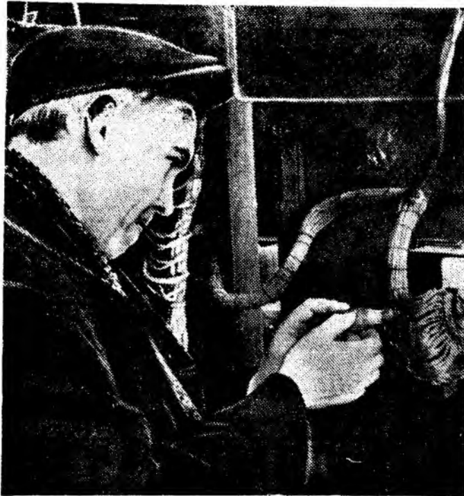
На снимке: инженер группы автоматики управления предприятий стройиндустрии Алексей Ключин ведет регулировку шагового искателя в релейном шкафу. Фото автора.
