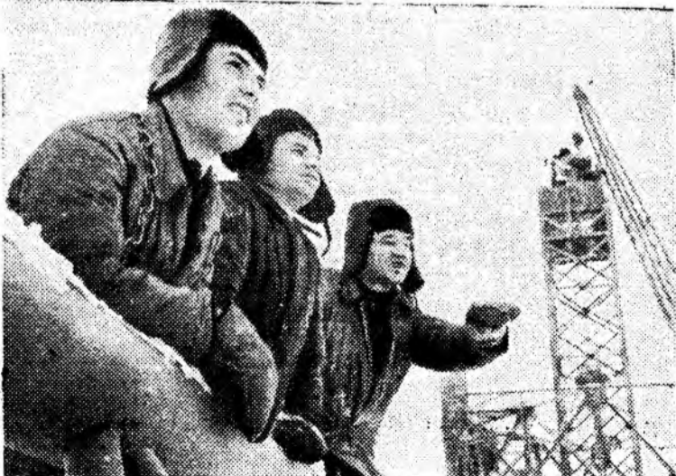
Калининская область. В 120 километрах от столицы на берегу Московского моря строится крупнейшая в мире Конаковская теплоэлектростанция мощностью 2 миллиона 500 тысяч киловатт. Она будет снабжать электроэнергией промышленные предприятия Москвы и Московской области, позволит электрифицировать ряд районов Калининской области.
