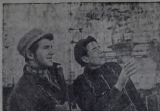
Донецкая область. На Ждановском металлургическом заводе имени Ильича растет новая доменная печь, названная именем XIV съезда ВЛКСМ. Строители ее несут трудовую предоктябрьскую вахту. Они борются за то, чтобы в этом году мощный агрегат вступил в строй.
