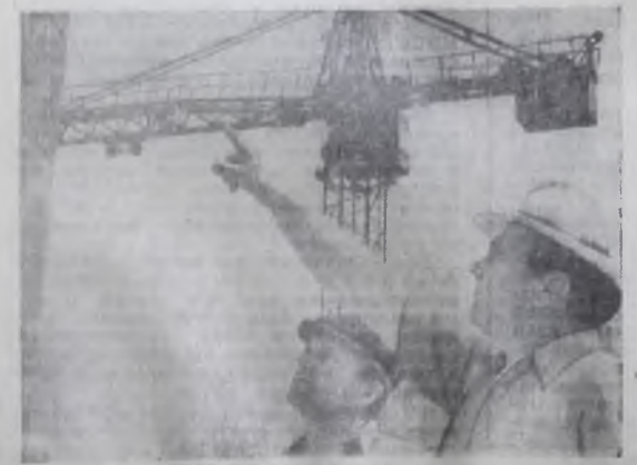
Бригада коммунистического труда домостроителей Владимира Пирого (СМУ-1) трудится в 179 квартале. Бригада строит детсад-асля в крупноблочном исполнении.
