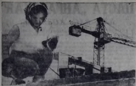
Валентина Омельченко заканчивает последний курс политехникума. Сейчас Валентина проходит производственную практику в бригаде коммунистического труда домостроителей Бориса Баженова (СМУ-1).
