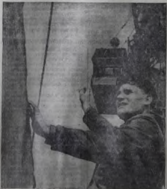
Идет установка очередной панели. Монтажник Борис Сергеевич Баженов ставит ее на свое место. Движения его точны, рассчитаны. Работает на строительстве жилых домов Борис Сергеевич почти с основания города. Он считается одним из квалифицированных монтажников.
