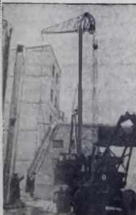
Азербайджанская ССР. Закончились промышленные испытания опытного образца самоходного подъемного крана, предназначенного для сельского строительства. Новый кран передвигается не на гусеницах, а на колесах. Грузоподъемность крана 3 тонны. На снимке: самоходный кран.
