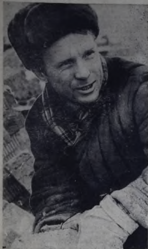
400 кубометров кладки — ко дню выборов в Верховный Совет СССР — таково обязательство бригады коммунистического труда Н. Турчина, сооружающей новый спортивный павильон.
