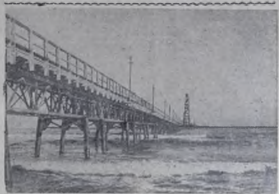
ДАГЕСТАНСКАЯ АССР. Далеко в море уходит эстакада промысла «Избербашнефть». Все процессы любви здесь автоматизированы и контролируются с диспетчерского пульта, находящегося на берегу. Несмотря на зимнюю непогоду, штормы, морские нефтяники наращивают темпы добычи. На снимке: эстакада промысла «Избербашнефть». Фото Р. Дика, Фотохроника ТАСС
