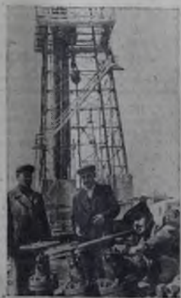
веряют фонтанную арматуру для установки на пробуренной скважине. Фото Г. Мочейкиса. Фотохроника ТАСС
