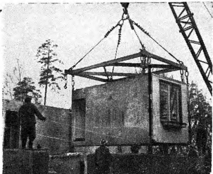
Ленинград. Строители треста № 104 Главленинградстроя начали монтаж первого в Ленинграде экспериментального восьмиквартирного дома из объемных элементов — блок-коробок, изготовленных и отделанных на заводе железобетонных изделий № 12. Такой метод строительства позволяет перенести большинство трудоемких операций в заводские условия. Это до минимума сокращает затраты труда на стройплощадке, значительно ускоряет строительство и удешевляет стоимость зданий.
