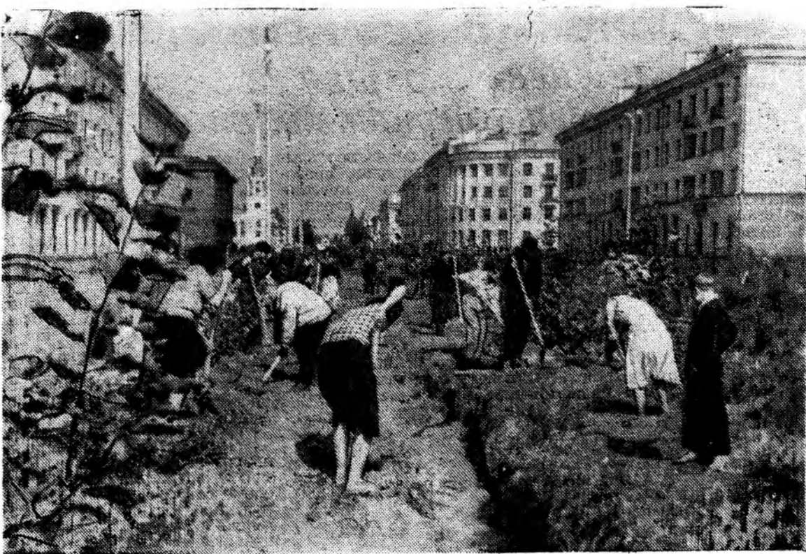
Хорошую помощь оказали строителям учащиеся 10, 17 и 26 школ. В один из теплых осенних дней ребята вышли на воскресник по заделке траншей газопровода. Отлично поработали все, но, пожалуй, самая большая производительность была у ребят из 26 школы. На снимке: школьники на воскреснике.
