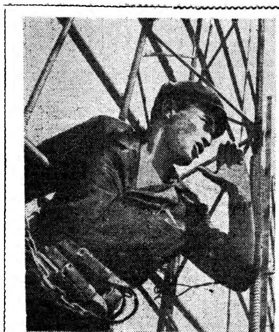
Дагестанская АССР. Строители Чирюртовской ГЭС, сооружаемой на левом берегу реки Сулак, настойчиво борются за досрочное окончание всех работ. В числе передовиков комплексная бригада бетонщиков, руководимая Магомедом Ункиловым. За отличные трудовые успехи этой бригаде присвоено почетное звание коллектива коммунистического труда.
