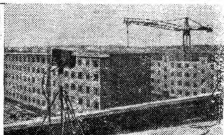
Ленинград. На строительстве жилых домов в 126-м квартале Шемиловки, где монтаж зданий ведет домостроительный комбинат № 2 Главленинградстроя, применена промышленная телевизионная установка ДТУ-4М. Четыре передающие камеры позволяют наблюдать ходом стройки на четырех участках. Телеустановка работает в комплексе с громкоговорящей диспетчерской связью.
