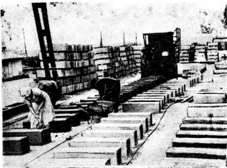
На снимке: комбайн по выпуску бордюрных камней, изготовленный коллективом завода ЖБИ-1.
