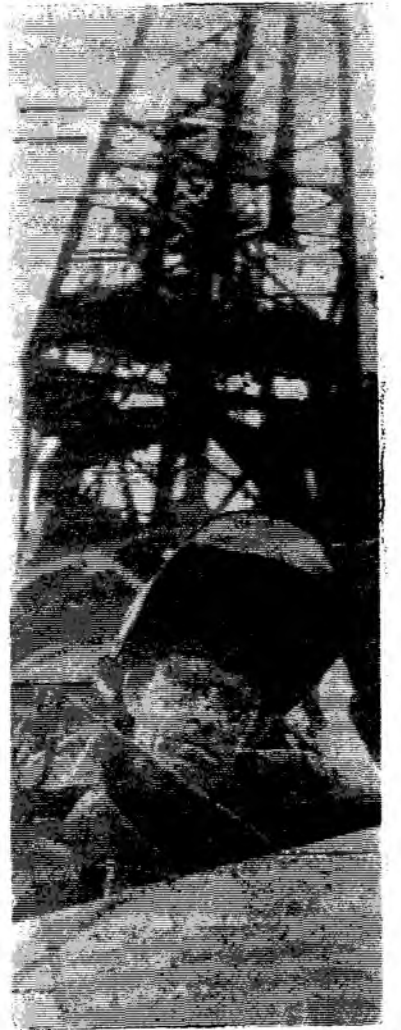
Замечательно трудится в эти дни сварщик монтажной конторы строительства ударник коммунистического труда Ф. М. Ткаченко. На снимке: Ф. М. Ткаченко за работой.
