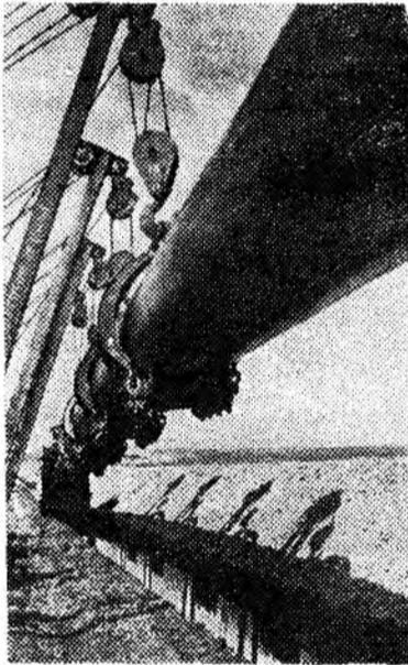
На территории Воронежской области ведется строительство участка газопровода Краснодарский край — Серпухов. Протяженность участка — 236 километров. Здесь работают четыре механизированные колонны 7-го строительного управления треста «Щекингазстрой», оснащенные новейшей техникой — мощными 20-тонными трубоукладчиками, очистительными и изоляционными машинами. В траншею укладываются трубы большого диаметра — 1020 миллиметров.
