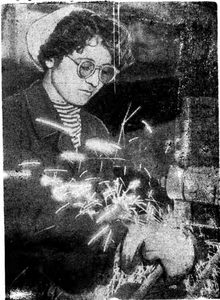
Завод железобетонных изделий № 2 с 22 апреля работает в счет майской программы. В успехах бетонщиков немалая заслуга арматурщиков, сварщиков, рабочих бетонного узла.
