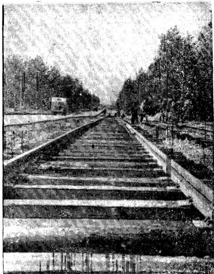
На строительстве 4-й линии трамвая.
