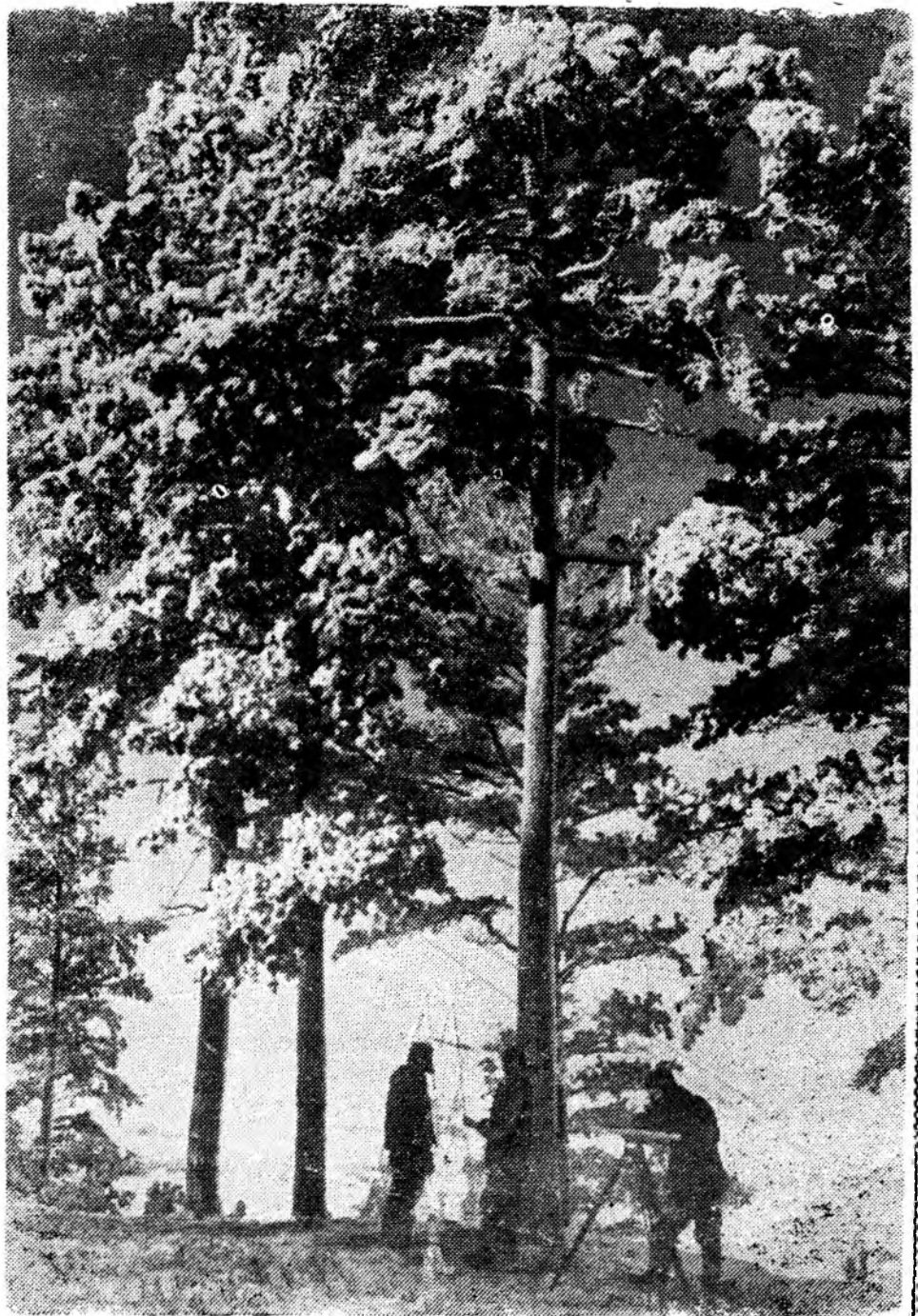
Здесь будет новый квартал. Первыми на место будущих домов и улиц придут геодезисты. Фотохуд. А. Елфимова.
