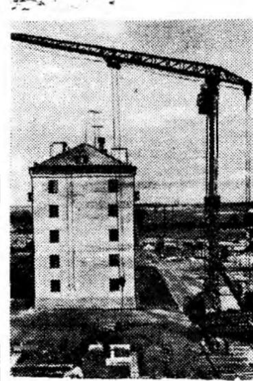
Москва. Оригинальную машину — шагающий башенный кран КТС-5-10 создал коллектив инженеров проектно-конструкторского бюро Главстроймеханизации Министерства транспортного строительства по проекту инженера А. Г. Лобова. Кран построен на Ржевском механическом заводе. Такой механизм создан впервые в мире.
