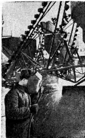
Тюменский завод строительных машин в минувшем году освоил производство передвижных бетонных заводов мощностью 80 кубометров бетона в смену. В этом году предстоит выпустить 10 таких заводов.
