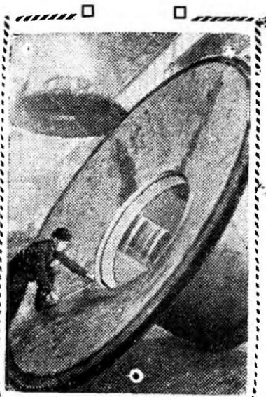
Куйбышевская область. На Сызранском заводе тяжелого машиностроения освоено выпуск шаровых мельниц «Ш-50». Этот новый тип мельницы производительностью 50 тонн в час предназначен для горнорудной промышленности и промышленности строительных материалов. На снимке: мастер участка механосборочного цеха И. Н. Романов проверяет горцевую стенку шаровой мельницы «Ш-50».
