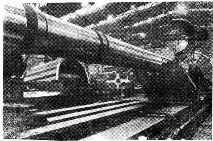
Свердловск. Уральский завод тяжелого машиностроения изготавливает ковочный пресс с усилием 6 тысяч тонн. Общий вес всей установки 1320 тонн.
