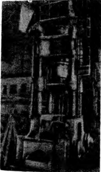
Новосибирск. На заводе имени Ефремова создана новая уникальная машина—гидравлический пресс модели П 404 усилием 1500 тонн для правки круглых металлических заготовок диаметром от 200 до 600 миллиметров. Первый такой агрегат коллектив изготовил по заказу Китайской Народной Республики.
