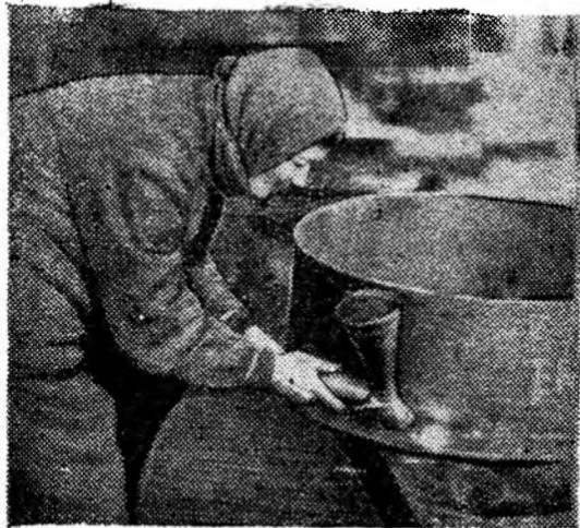
Анна Васильевна Сидорова — одной из первых в прорабстве № 1 заготовительного района монтажной конторы строительства освоила автоматическую сварку под флюсом. Она систематически перевыполняет дневные нормы.
