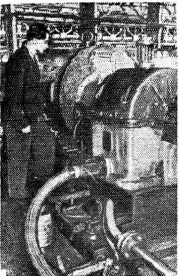
Ленинград. На Невском машиностроительном заводе имени В. И. Ленина построен первый опытный компрессор типа «Н 280-11-1» мощностью 280 кубических метров газа в минуту. Новая машина создает очень высокое давление (до 57 атмосфер) и предназначена для подкачки газа на строящейся линии газопровод Ставрополь — Москва. В будущем компрессоры этого типа будут устанавливаться на газопроводах, строительство которых намечено осуществить в шестой пятилетке.
