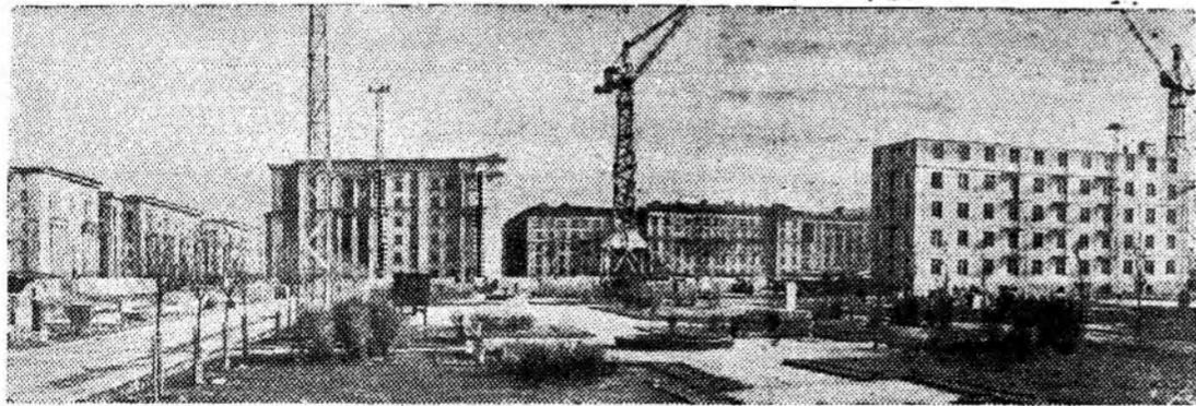
Ленинград. В Невском районе в 122 квартале Большой Шемиловки идет сооружение жилых домов из крупных панелей. За 35 дней монтажники полностью закончили сборку пятиэтажной стены и перекрытий дома, а через 75 дней со дня начала строительства ленинградцы отпразднуют новоселье. На сооружение каждого этажа дома бригада А. Демидкина, состоящая из 8 монтажников и двух сборщиков, затрачивает 7 дней. Всего здесь будет построено 8 пятиэтажных корпусов. Весь квартал занимает 7,5 гектара, из них
