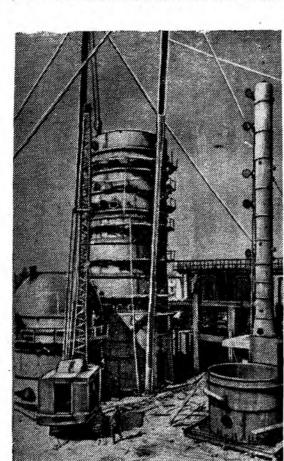
На монтажной площадке, как всегда, оживленно. Сверкают ог- вят конструкции к подъему, дру- перь подходящие». на сорокаметровой высоте работают такелажники, внизу, слесарисборщики с помощью крана монтируют очередную секцию дистилляционной колонны.
