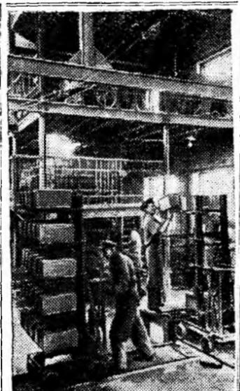
**Нальчик.** Недалеко от Нальчикского карьера вулканического пепла и пемзы построен завод строительных блоков производительностью 6—7 тысяч штук в сутки. Каждый блок в стеной кладке заменяет семь кирпичей. Блоки из вулканического пепла не требуют обжига, обладают высокой прочностью и теплоизоляцией. Строители Кабардинской республики используют этот дешевый материал при возведении зданий. В ближайшее время завод удвоит количество выпускаемых блоков.
