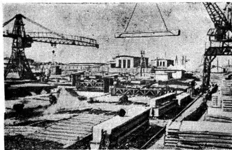
Алтайский край. В марте этого года закончено строительство второй очереди открытого полигона комбината производственных предприятий барнаульского треста «Стройгаз». Его производственная мощность — 15 тысяч кубометров крупноразмерных железобетонных конструкций в год. План первого квартала выполнен на 116 процентов, апрельский — на 220. Сейчас коллектив полигона выполняет заказ для строительства зерноскладов в районе целинных и залежных земель Алтая.
