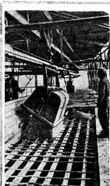
Грузинская ССР. Цементный завод в Каспи пятый пятилетний план перевыполнил. В результате реконструкции работающих цементных печей, увеличения их рабочей площади, установки новых мельниц, мощность завода возросла более чем на 20 процентов.
