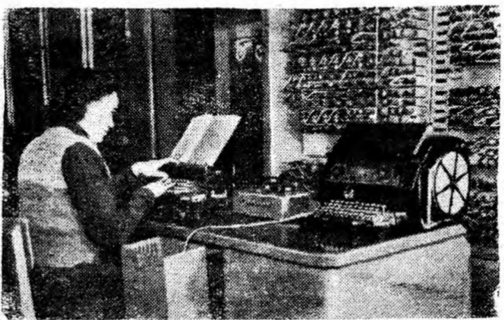
Быстродействующая электронная счетная машина «БЭСМ», которая производит сложную вычислительную работу, может быть использована не только для решения математических задач, но и для других научных целей. В порядке пробы недавно эта машина производила автоматический перевод с английского языка на русский язык.
