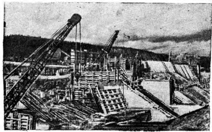
Башкирская АССР. На строительстве Уфимской ГЭС. На снимке: бетонные работы на строительстве плота.
