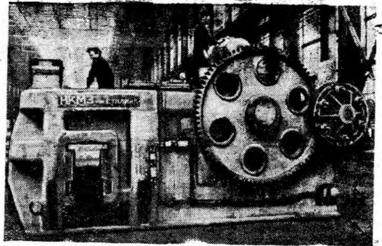
Сталинская область. Механический цех № 7 общего машиностроения Ново-Краматорского завода имени Сталина выпускает краны, прокатное, кузнечно-прессовое и другое оборудование для строящихся гидроэлектростанций. Производственный план коллектив систематически выполняет. Передовая бригада коммуниста И. В. Ботина ведет сборку горизонтально-ковочной машины давлением 1200 тонн. Она предназначена для одного из заводов Китайской Народной Республики.
