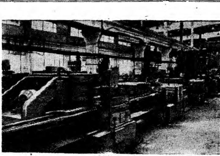
Московский станкостроительный завод имени Серго Орджоникидзе — передовое предприятие станкостроительной промышленности. С начала года станкостроители выпустили более ста агрегатных станков новой конструкции. На днях коллектив сборщиков раньше срока закончил сборку и испытание новой автоматической линии, предназначенной для фрезерной обработки головок блока цилиндров трактора ДТ-54.
