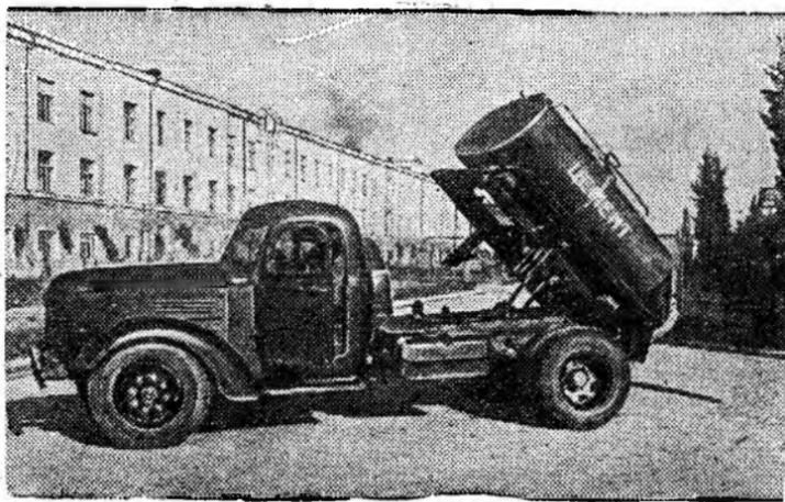
Грузинская ССР. На Бутаисском автозаводе создан новый образец самосвала-цементовоза на базе автомобиля КАЗ-5856. Цистерна при разгрузке цемента опрокидывается с помощью двух гидравлических двухцилиндровых подъемников. Для очистки цистерны от остатков цемента на дне ее устроены два пневматических вибратора. Установлен указатель наполнения цистерны цементом. В этом году завод выпустит 700 самосвалов-цементовозов.
