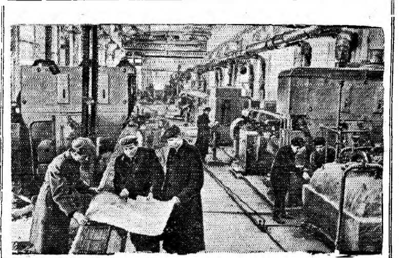
Алтайский край. На заводе «Алтайсельмаш» заканчивается монтаж автоматических линий, на которых будут изготовляться лемеха и отвалы к плугам. Две линии будут выпускать 2.200 тысяч лемехов и одна линия — 600 тысяч отвалов в год.
