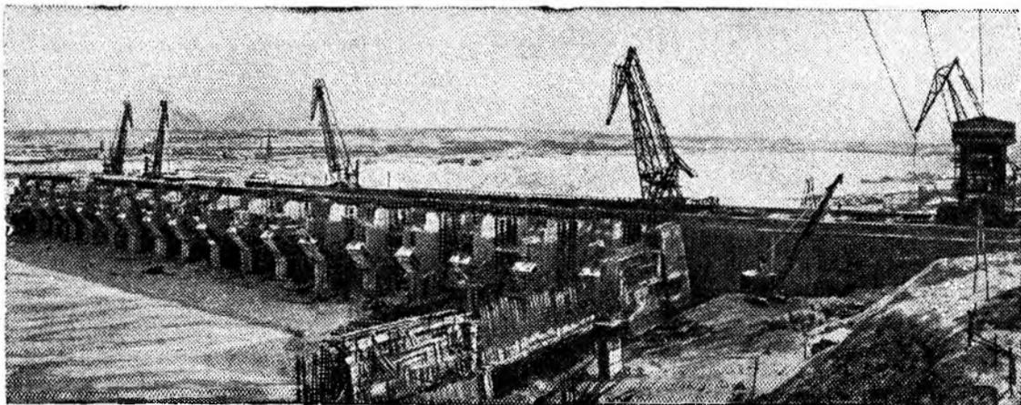
На строительстве Камской гидроэлектростанции заканчивается сооружение мощной железобетонной водосливной плотины и готовится к пуску первый плуз, по которому уже в этом году будет пропускаться славяемый по Каме лес.
