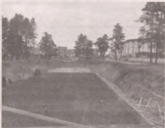
■ 16 июня 2021 года. Стройка идёт ударными темпами.
