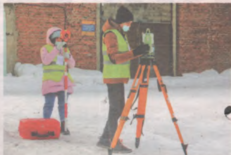
■ Работа геодезиста всегда на улице. Студенты выполняют разбивку поля.
