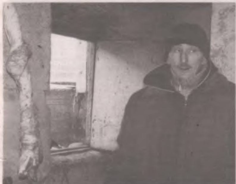
■ Дворник показывает окно, через которое в подвал был свободный доступ.
