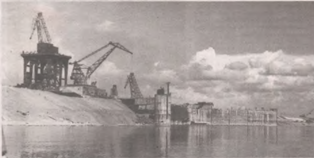
■ Строительство Китойского моста.
