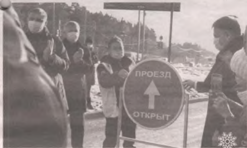
■ Завершено строительство второй полосы Ленинградского проспекта
