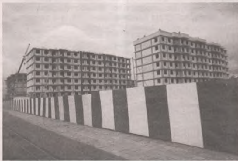
■ Строительство домов в Тулуне.
