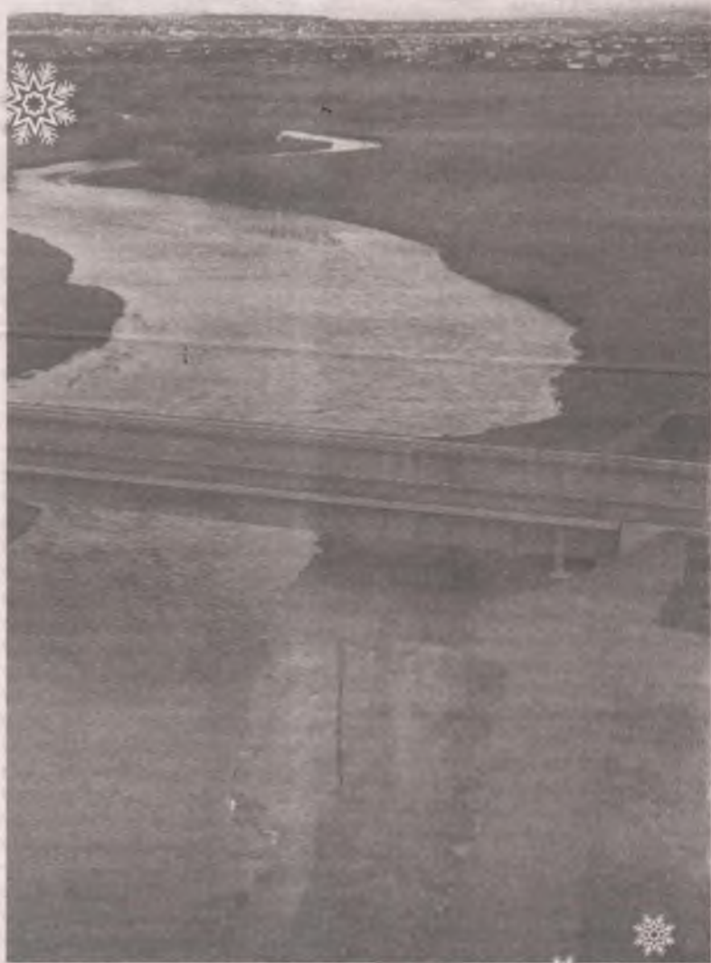
■ Новый мост через реку Куду.
