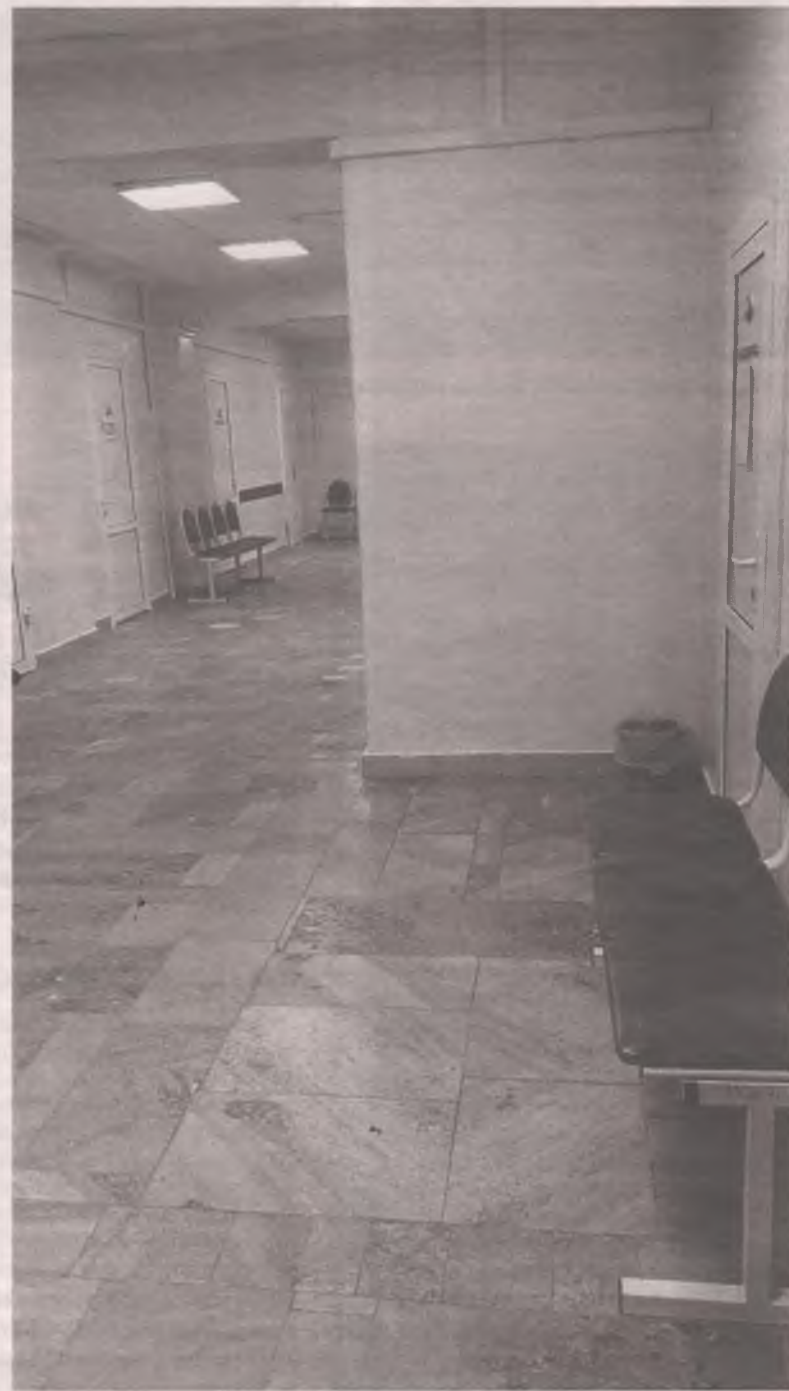
■ Коридор МАНО, в котором работает сейчас ковидный госпиталь.
