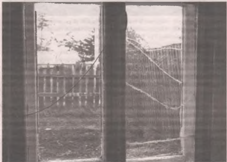
■ Окна держатся на честном слове: рамы прогнили, в стёклах крупные трещины, в проёмах щели.
