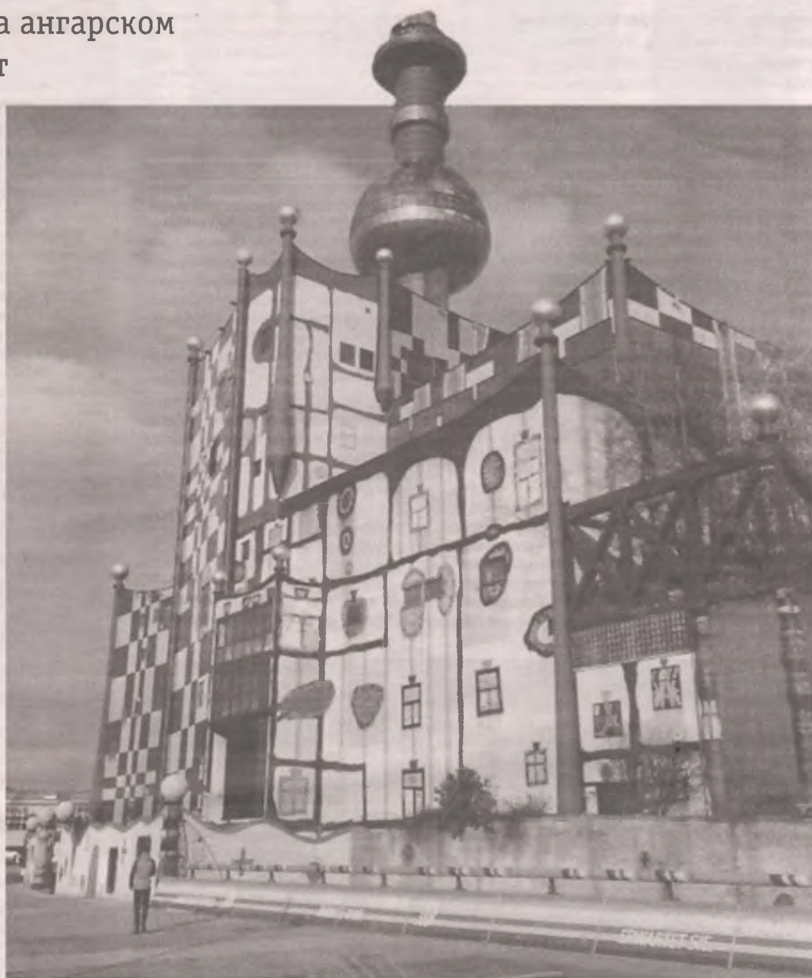
■ Этот шедевр архитектуры – мусоросжигательный завод в Вене, находится в центре города. Сжигает 250 тысяч тонн мусора в год, производит электроэнергию и горячую воду и не загрязняет воздух. Оказывается, такое возможно. В Вене.
